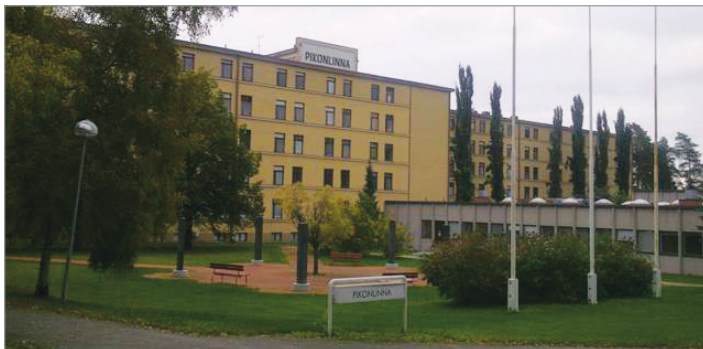
Hospital Pikonlinna, protegido con sistema de agua nebulizada a alta presión SEM-SAFE® de Danfoss.
