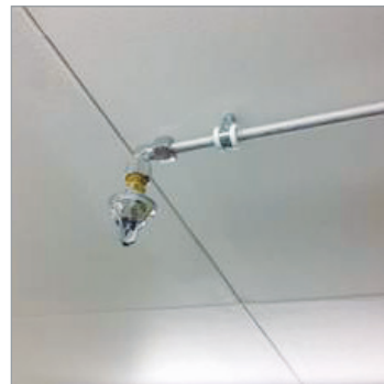
Boquilla de agua nebulizada a alta presión SEM-SAFE® de Danfoss.
